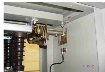
Cierre rápido por medio de resorte, colocado en la flecha de la cuchilla de operación sin carga.
